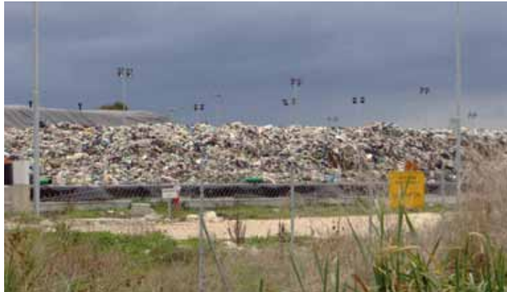
Il sito di stoccaggio temporaneo di Ferrandelle (Ce). La sua costruzione, troppo vicina a una falda acquifera, avrebbe inquinato irrimediabilmente il territorio circostante.
